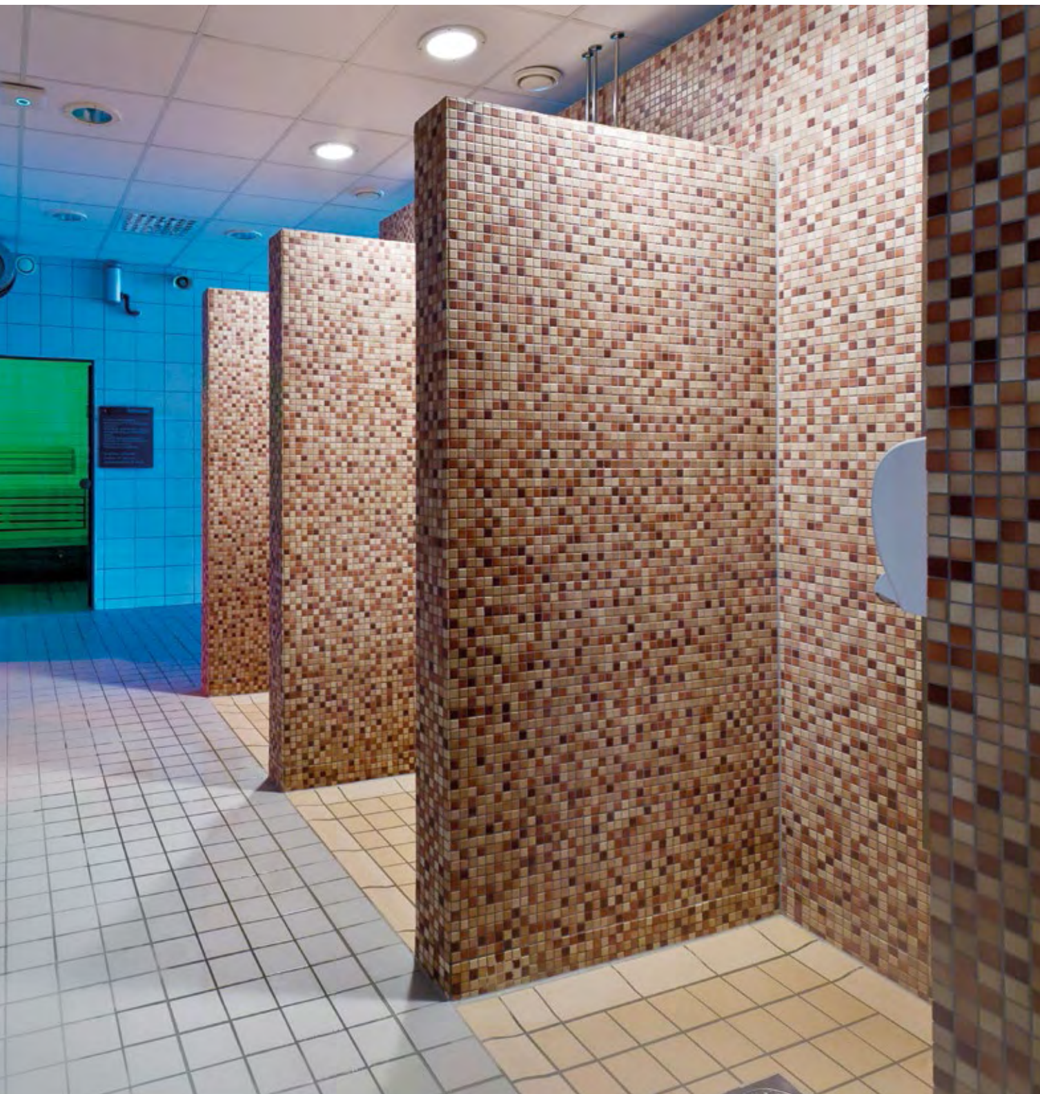
Skien Fritidspark, Moflatveien, Шиен, Норвегия · Архитектор: Arkitektkontoret Nils Tveit AS · Фото: Том Рийс
