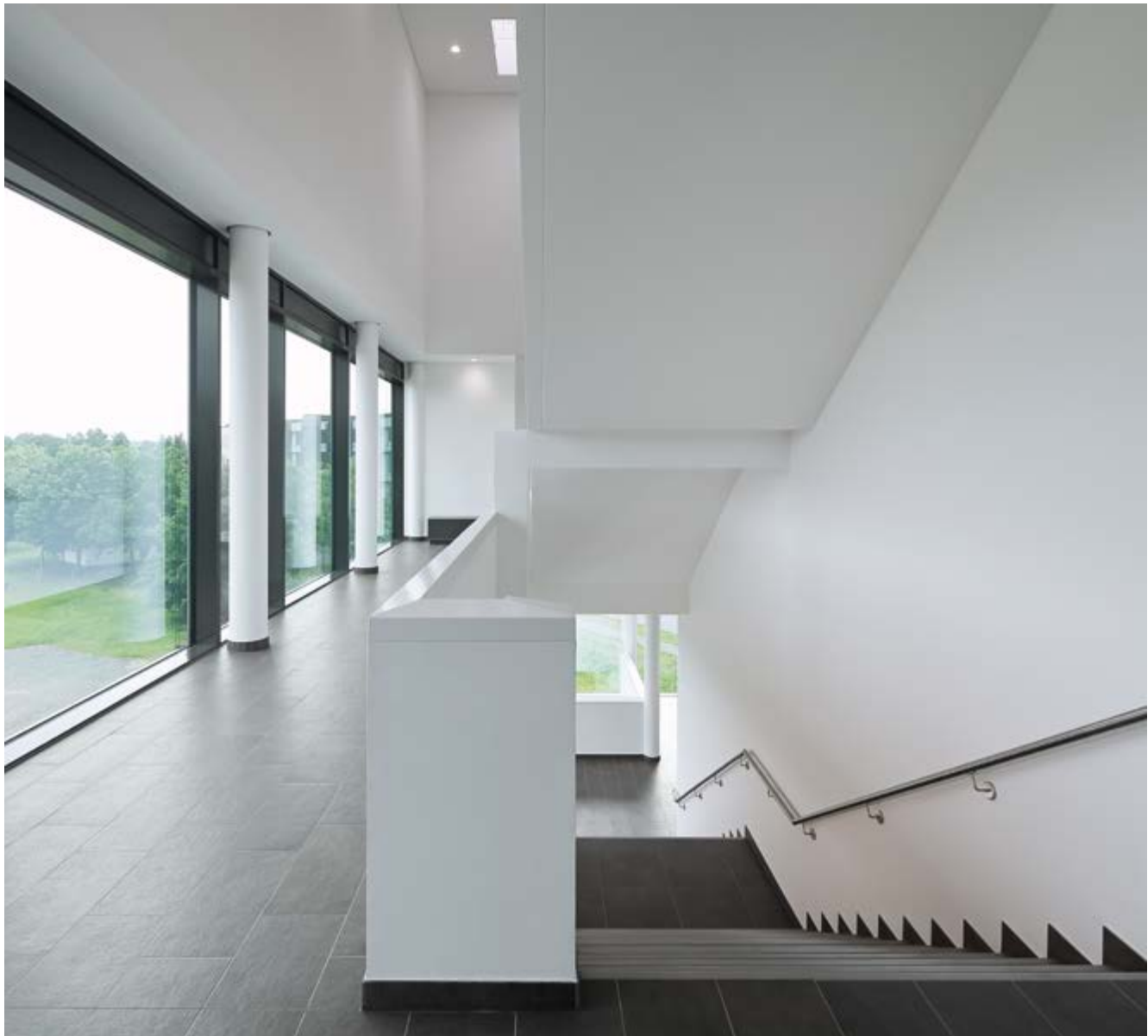
Seminar-Gebäude „Philosophikum“ · Seminar Building Philosophikum, Gießen, Deutschland · Germany Architekt · Architect: pbr Architekten und Ingenieure / Photo: Hans-Jürgen Landes
