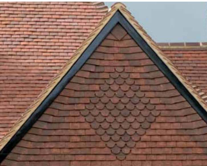
14 Отделка верхней части крыши ( фронтон), декоративная черепица на стене
