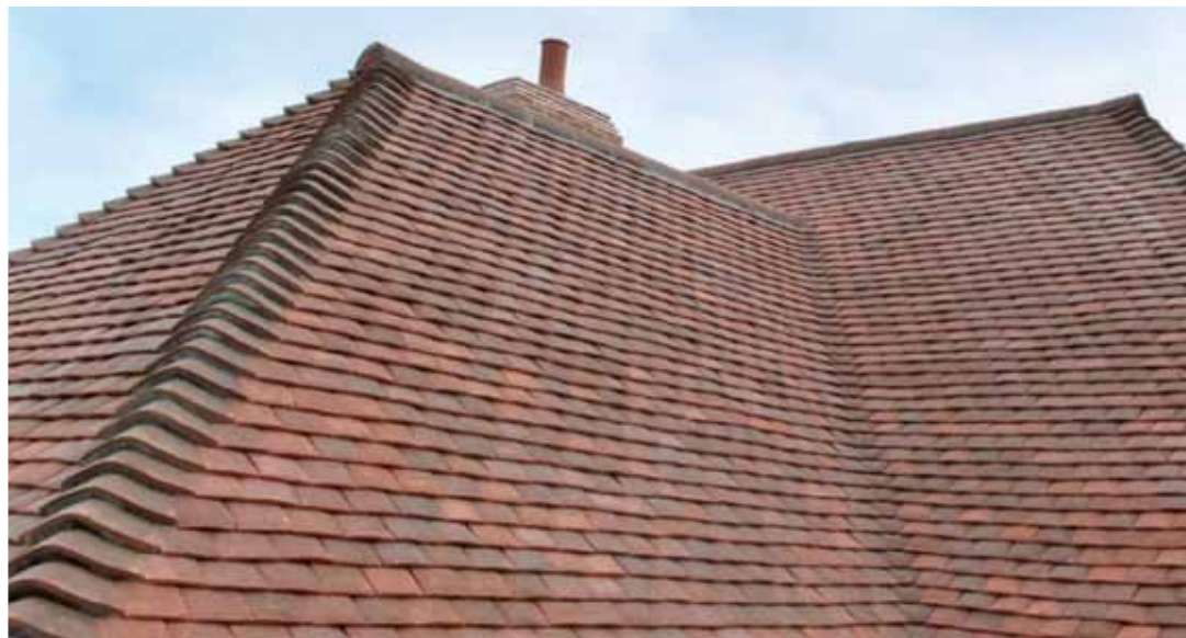
Хребет крыши и ендова с применением хребтовой и ендовой черепицы
